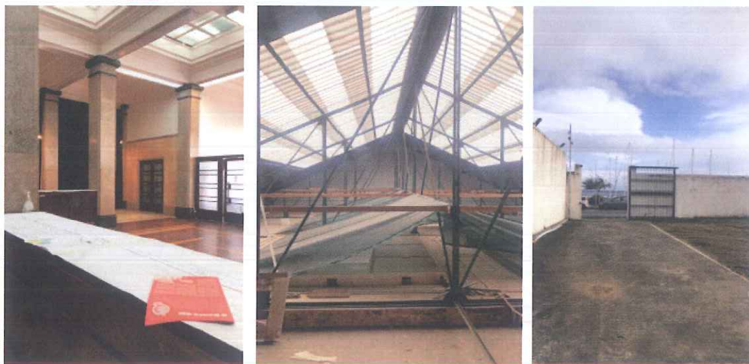
Imagens do BA: sala polivalente, cobertura e logradouro voltado para o mar.
